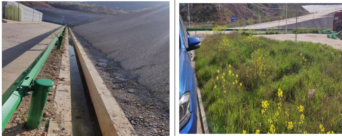
图 4-3 已实施的临时措施
