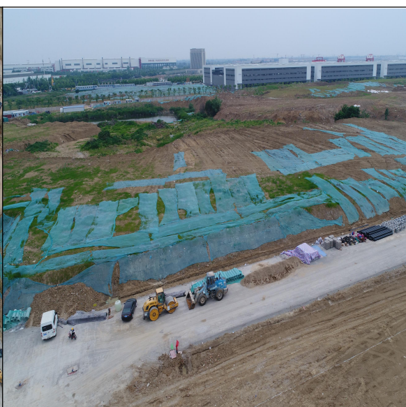
临时堆土区临时苫盖
